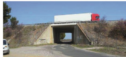
6 Ouvrage de franchissement inférieur de l'autoroute par l'ancien chemin de Salses
